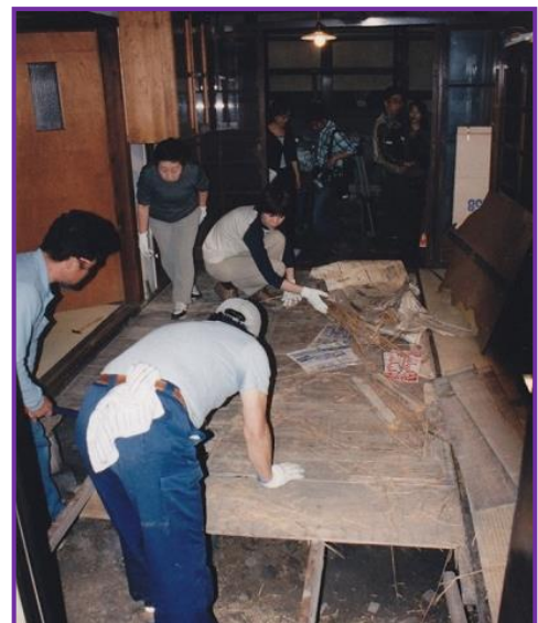
【2001.5.19 市民参加型による改修工事の様子】
