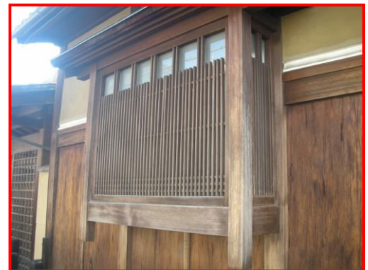
【大塀造りの出窓屋根は柿の上に銅版が】
