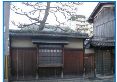
【既に解体されたが向側に建っていた住宅】
