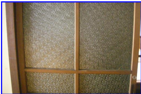
洋室入口のガラス戸
